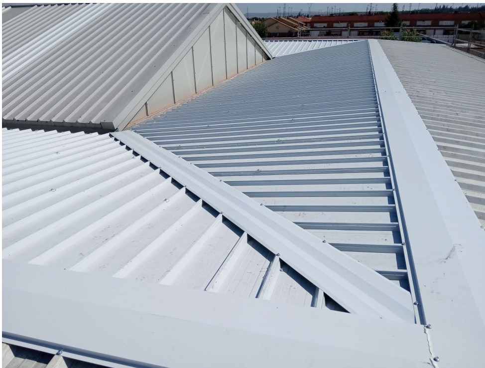
FOTOS 1 Y 2: Vistas de la cubierta reformada.
