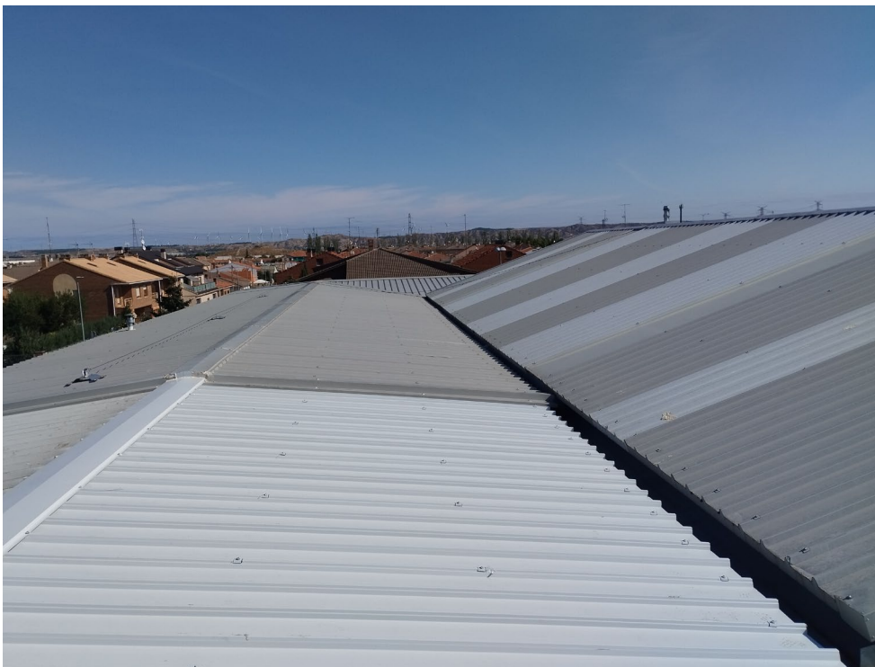
FOTOS 4 Y 5: Encuentros de la cubierta reformada con la del resto del edificio. Se puede observar en la foto superior el aumento de la sección de los canalones.
